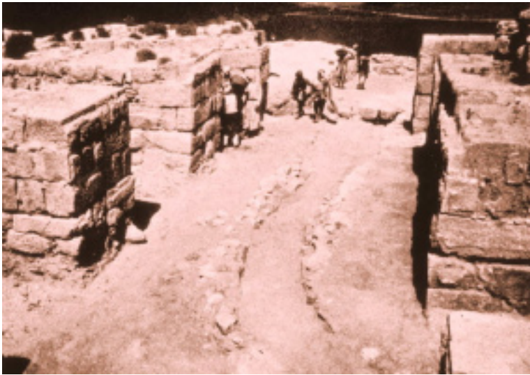
Puerta de Meguido antes del desmonte de un lateral
