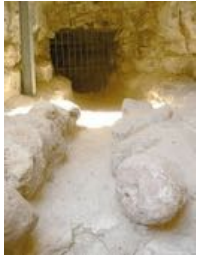
Boca del túnel de recogida de agua del arroyo Nahal Hebrón
